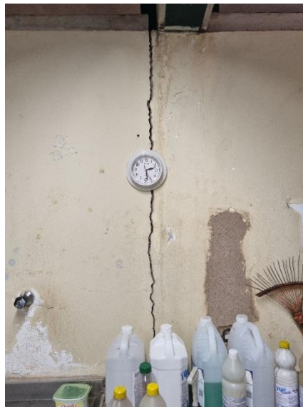
Figuras 21 e 22: Rachaduras no elemento vertical da estrutura da parede
