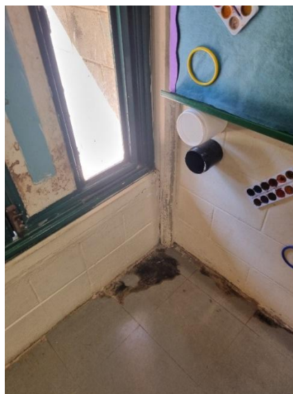
Figuras 23 e 24: Trincas na parede e infiltração nas paredes das salas de aula em uso
