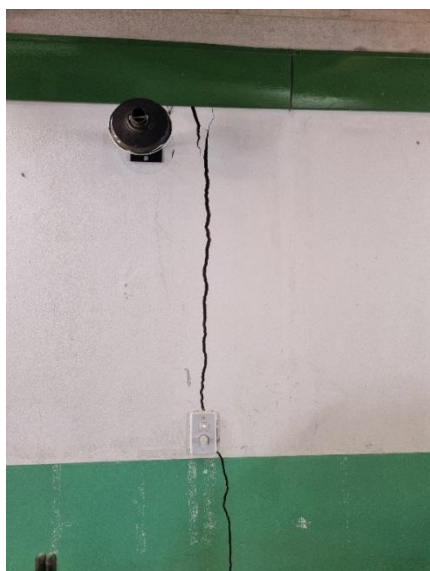
Figuras 17 e 18: Trincas verticais na face interna das paredes das salas interditadas
