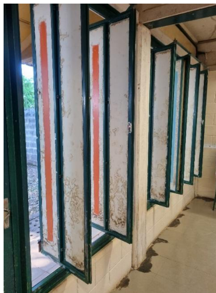
Figuras 1 e 2: Esquadrias (portas e janelas) danificadas com MDF estufado
