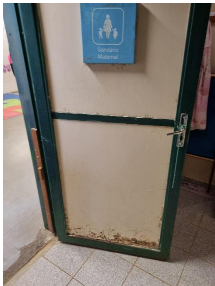
Figuras 1 e 2: Esquadrias (portas e janelas) danificadas com MDF estufado
