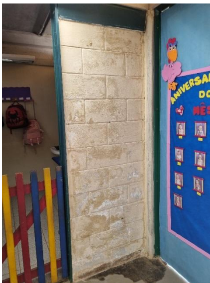
Figuras 5 e 6: Manchas e mofo causadas pela infiltração nas paredes
