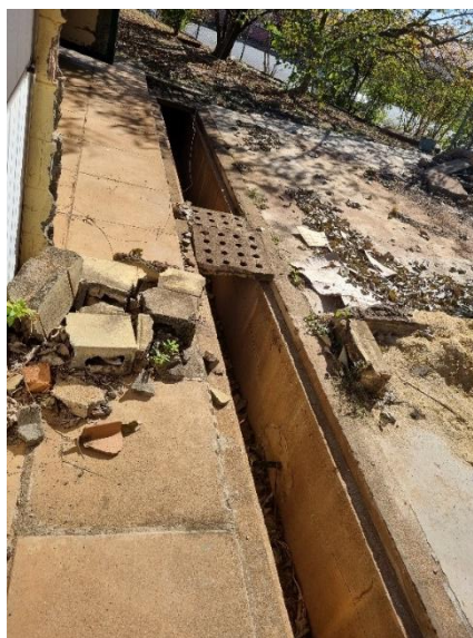
Figuras 27 e 28: Área externa com muro destruído e grelhas do ralo danificadas
