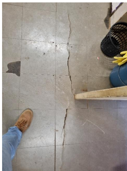
Figuras 11 e 12: Piso danificado com rachaduras e trincas e infiltração ascendente
