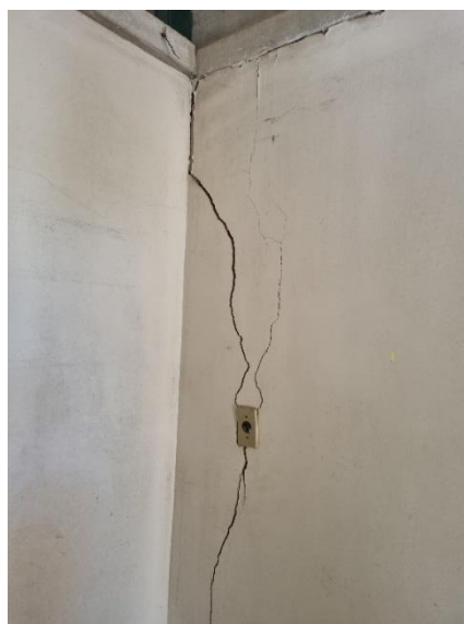
Figuras 17 e 18: Trincas verticais na face interna das paredes das salas interditadas
