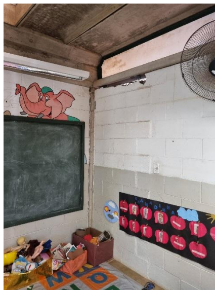
Figuras 25 e 26: Trincas e rachaduras nas paredes e infiltração na cobertura das salas de aula em uso
