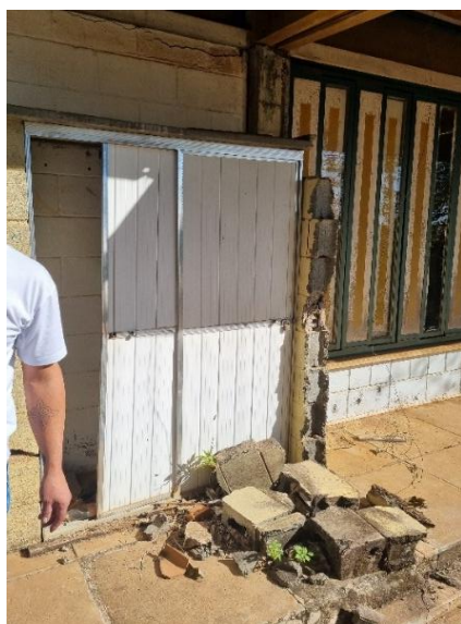
Figuras 27 e 28: Área externa com muro destruído e grelhas do ralo danificadas
