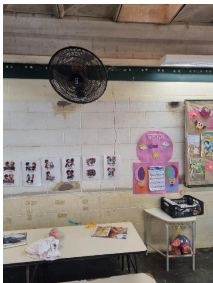
Figuras 23 e 24: Trincas na parede e infiltração nas paredes das salas de aula em uso
