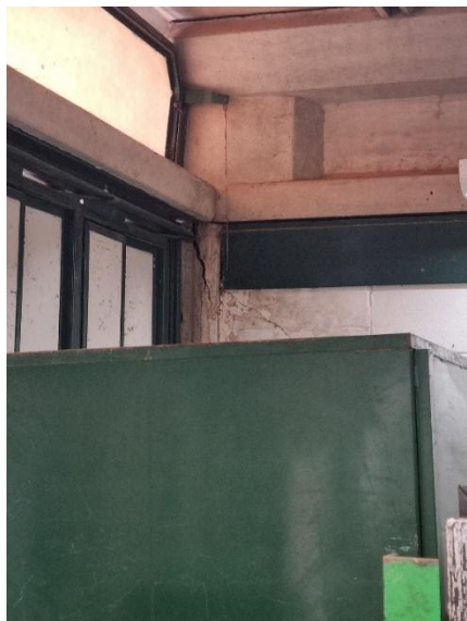
Figuras 21 e 22: Rachaduras no elemento vertical da estrutura da parede
