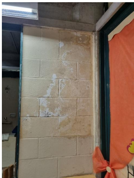
Figuras 5 e 6: Manchas e mofo causadas pela infiltração nas paredes
